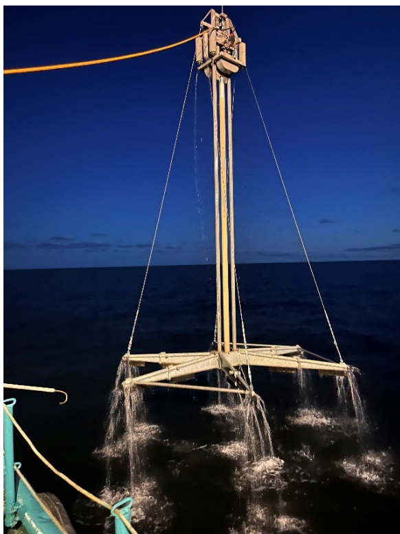
Pav. 3. Vibro gręžimo prietaisas
